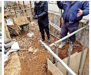
現地調査風景
